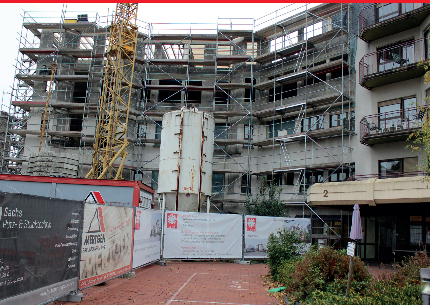
Die Großbaustelle in der Lahnsteiner Innenstadt: Das Caritas-Altenzentrum St. Martin wird derzeit aufwendig saniert und umgebaut. Unter anderem wurde der linke Gebäudeteil um zwei Etagen aufgestockt. Dieser Bereich soll im Sommer dieses Jahres fertig sein. Das Ende der kompletten Arbeiten ist für 2019 geplant.
